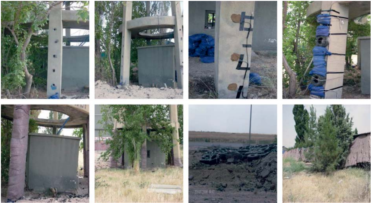
Şekil 7 - Patlatma öncesinde yapılan hazırlıklar
