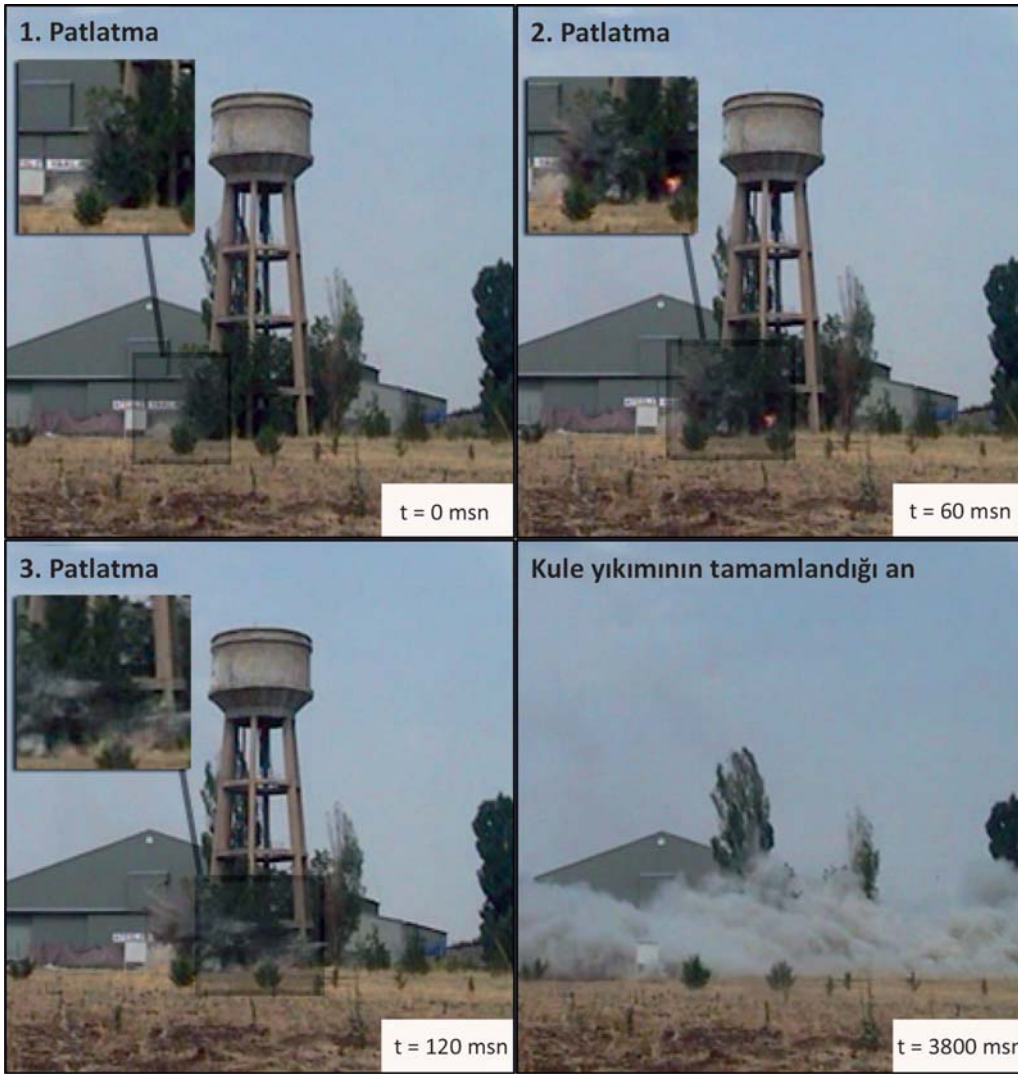
Şekil 9 - Su kulesinin yıkılışındaki patlatmalar ile kule yıkımının tamamlandığı an
